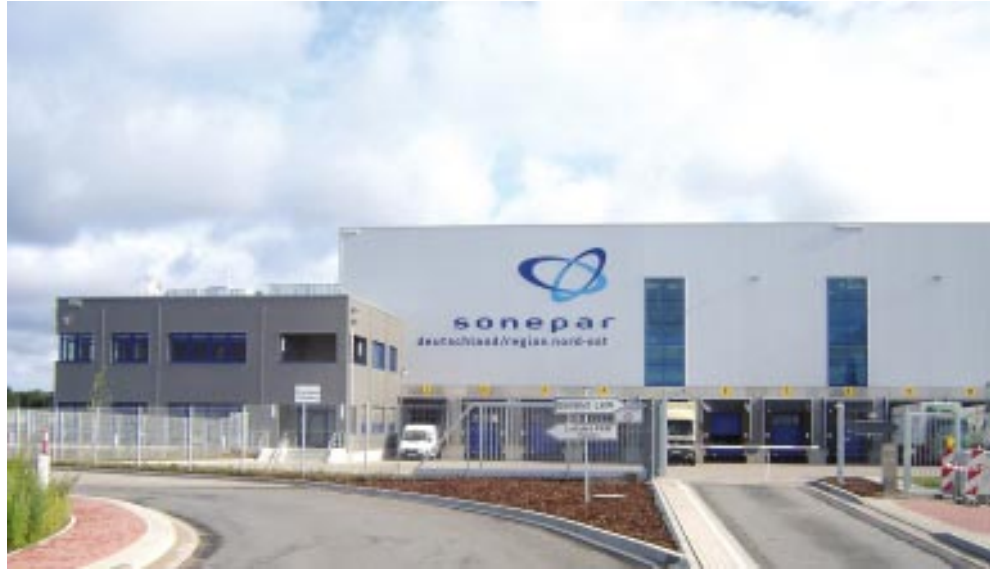
Zentrallager Sonepar Deutschland Region Nordost in Garbsen bei Hannover.
